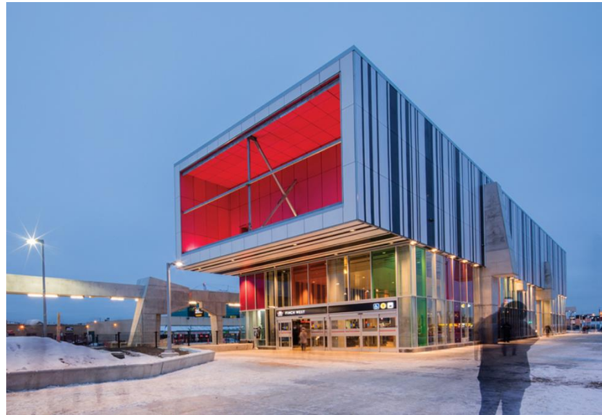
Exemple architectural - station de métro à Toronto
