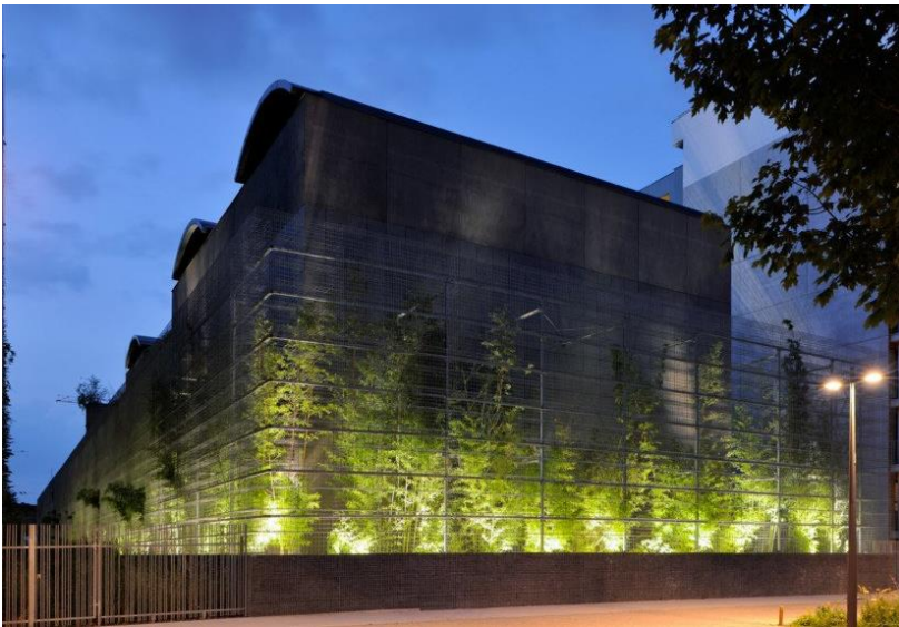
Poste électrique à Lyon
