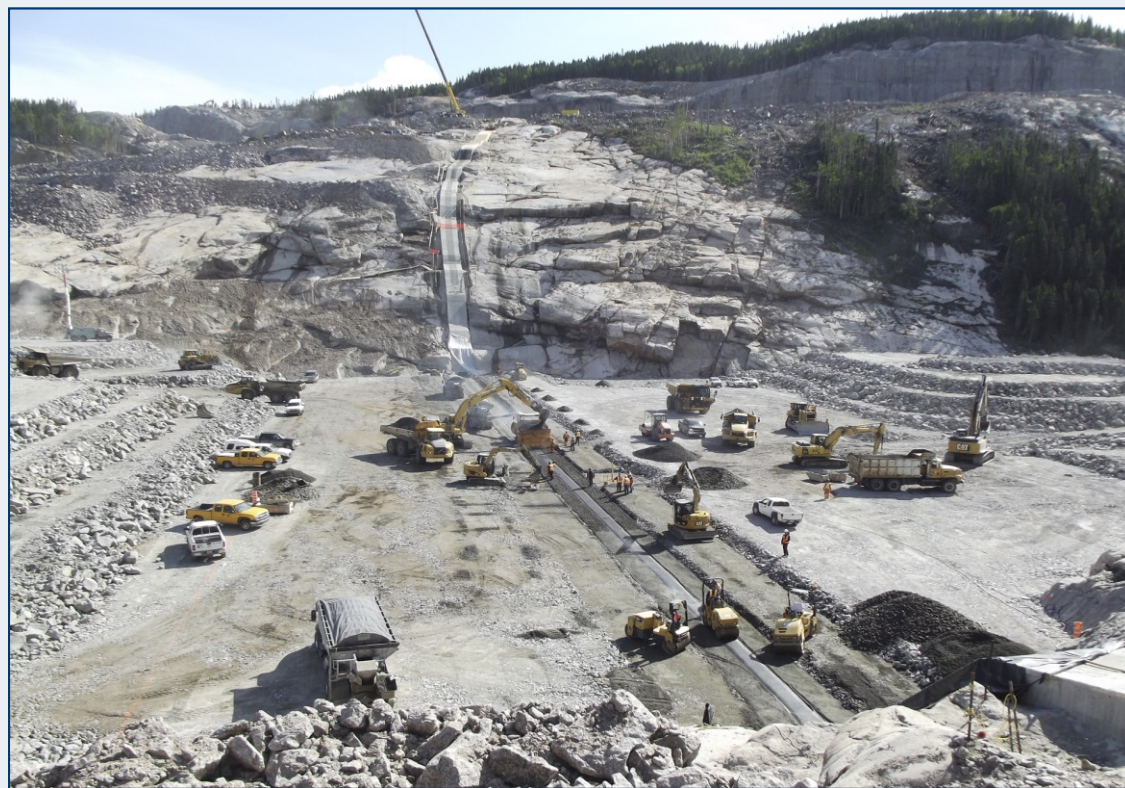
Construction du socle de béton et du noyau de béton asphaltique du barrage de la Romaine-2
